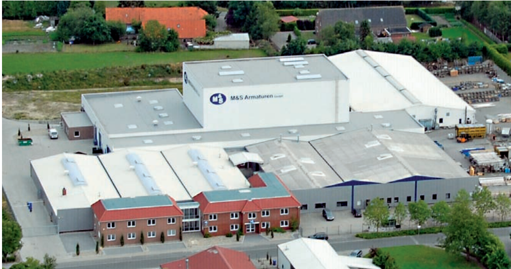
M&S Armaturen GmbH, Friedeburg
